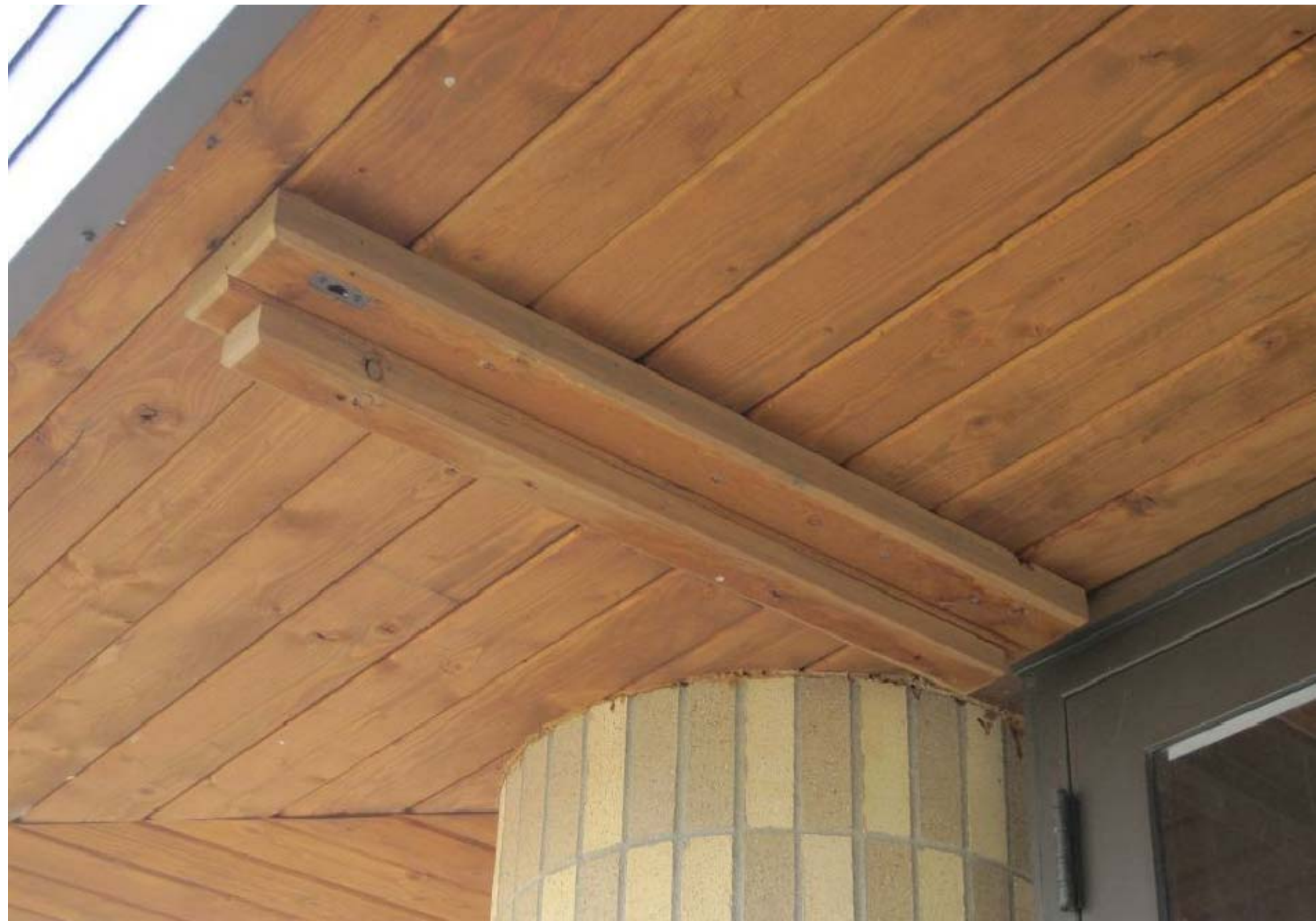
1E L-3 REFERENCE PHOTO EXISTING EAVE MOUNTED DOOR STOP (END DOORS)
